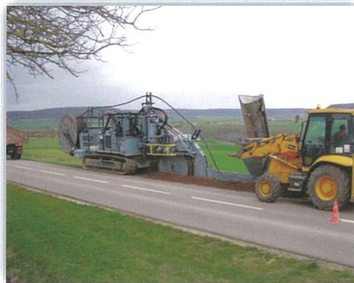
Réalisation de la tranchée
