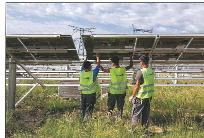
Pose de modules
