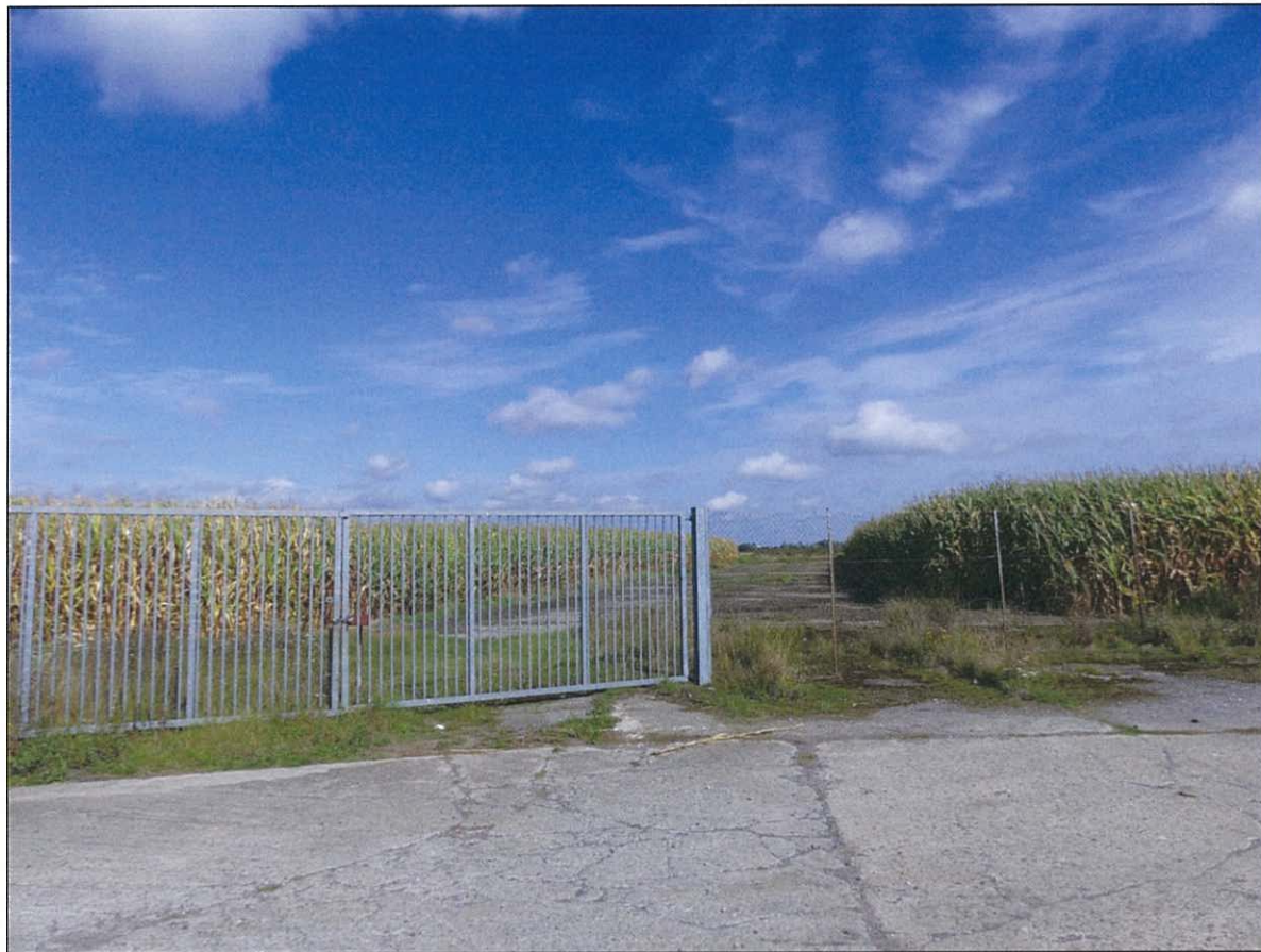
Clôture et portail sur toute la limite Ouest de l'aéroport (MICA Environnement, septembre 2021)
