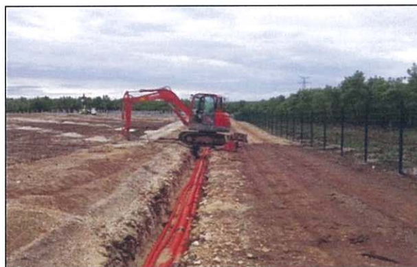
Enfouissement des réseaux
